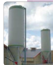
Диаметр бункера 2,4 метра, высота купола 0,6 метра, глубина конуса 1,95 метра, угол конуса 60°
